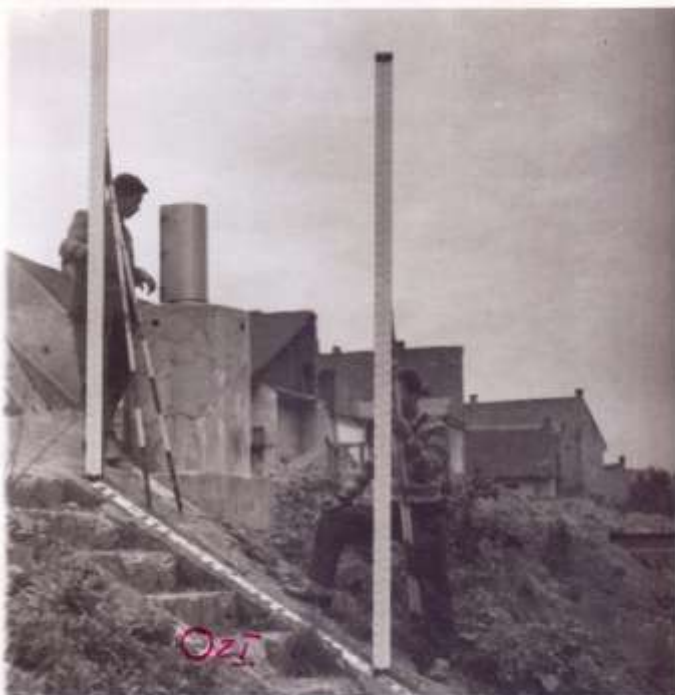
B. Bystrica: Vodáreň a ZI.
