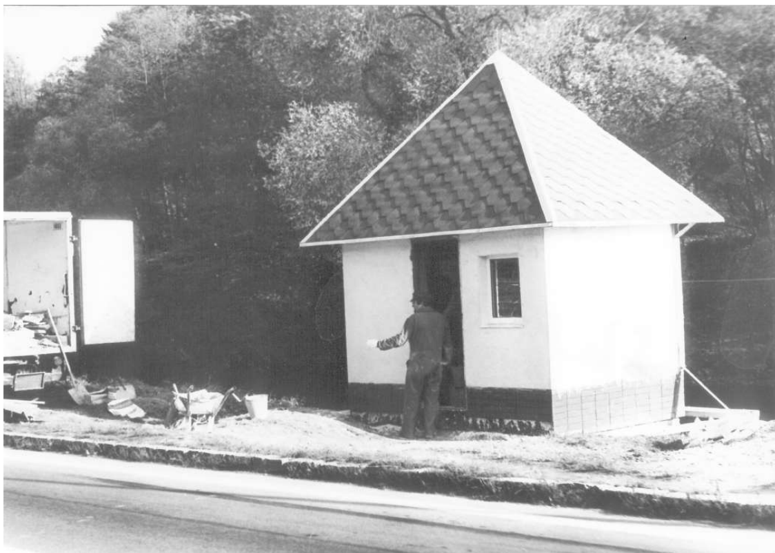
Výstavba murovanej vodomernej stanice na Hrone v roku 1994 - archív RP SHMÚ Banská Bystrica
